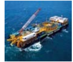
海底送電ケーブル敷設の様子
