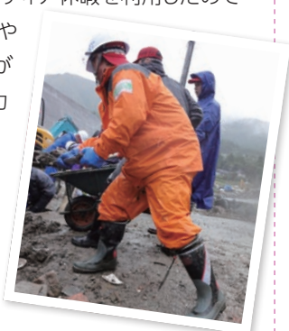
大船渡市での作業の様子
