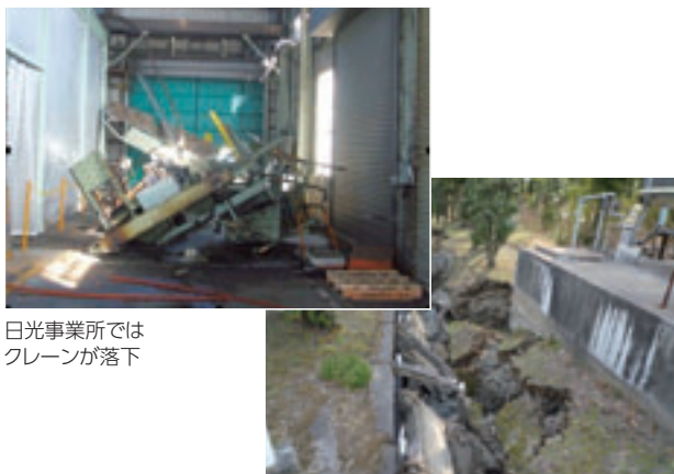
千葉事業所では中央排水溝が崩壊
