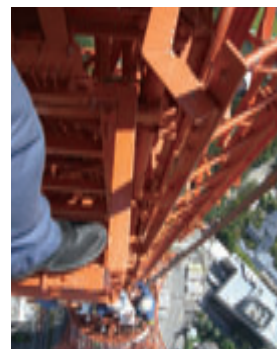
東京タワーのアンテナ緊急点検の様子
