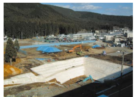
栃木金属工業の土壌対策現場
