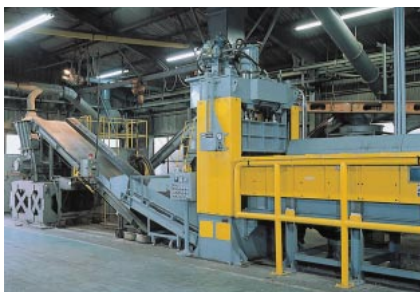
自動化された解体設備
