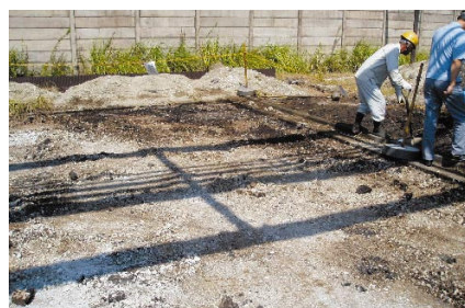
千葉事業所 土入れ替え作業
