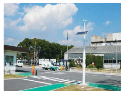
風力太陽光発電街灯
