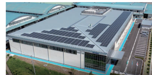
東京特殊電線(株)が設置した太陽光発電パネル(2021年1月稼働開始)
