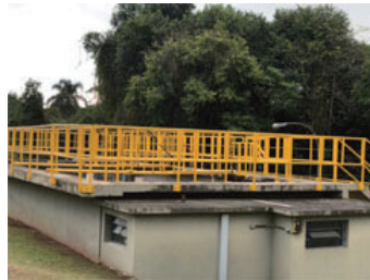
河川の自然状態を確保するための処理済み排水排出/パラメータの監視と制御(Furukawa Electric LatAm S.A.)
