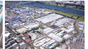
平塚事業所で水力発電由来のグリーン電力導入(2021年4月稼働開始)
