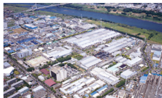
平塚事業所で水力発電由来のグリーン電力導入 (2021年4月稼働開始)
